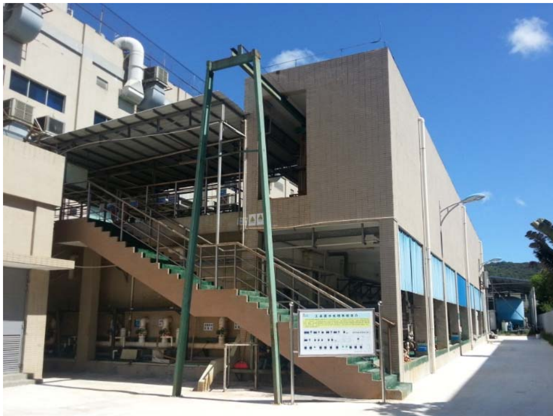
公司污水处理系统设施 ↑
