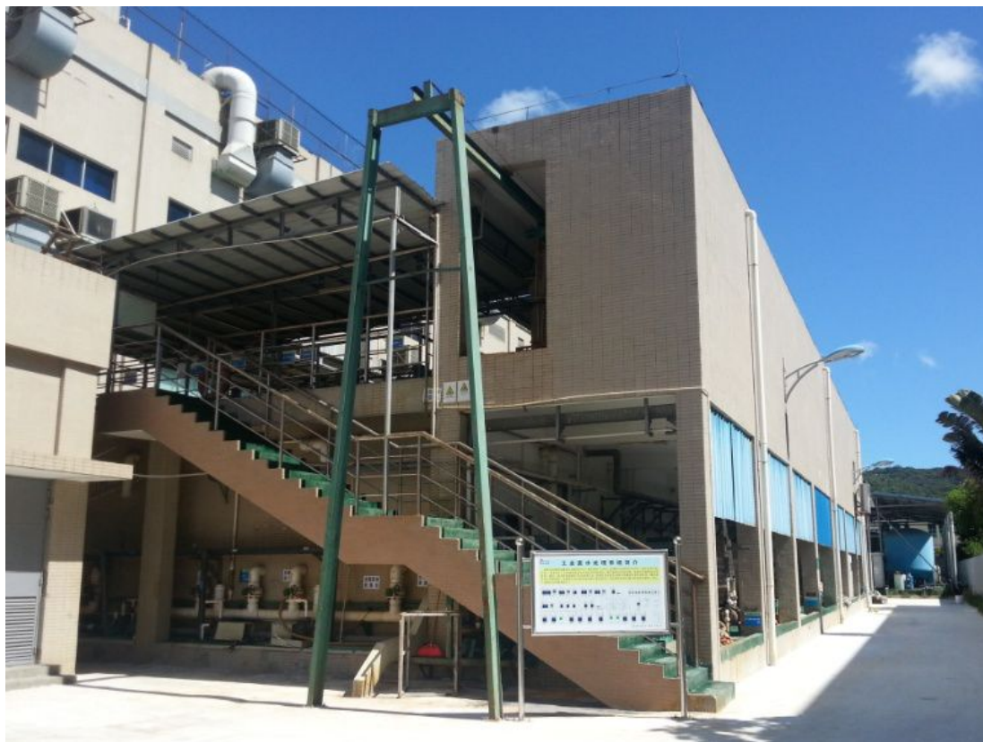
标的公司污水处理系统设施↑
