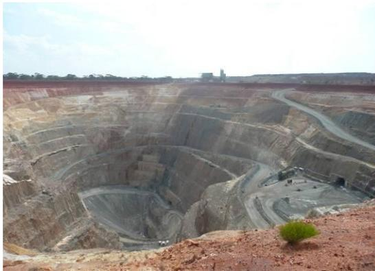
图 9 凹陷台阶+平巷+车载斜坡联合开采
